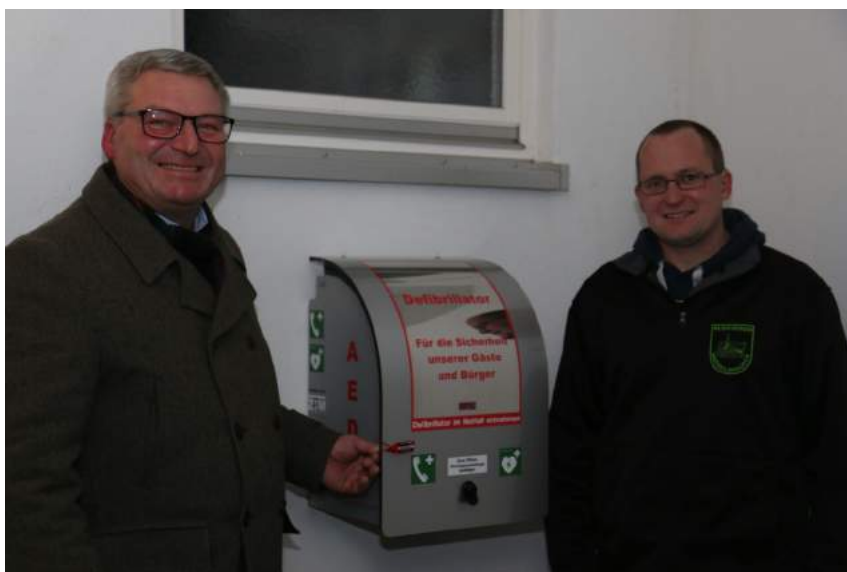
Foto: Bürgermeister Georg Menninger freut sich zusammen mit Musik-Vorstand Michael Slabsche, dass jetzt der Defibrillator im Eingangsbereich der Gästehaus-Kegelbahn installiert wurde.
